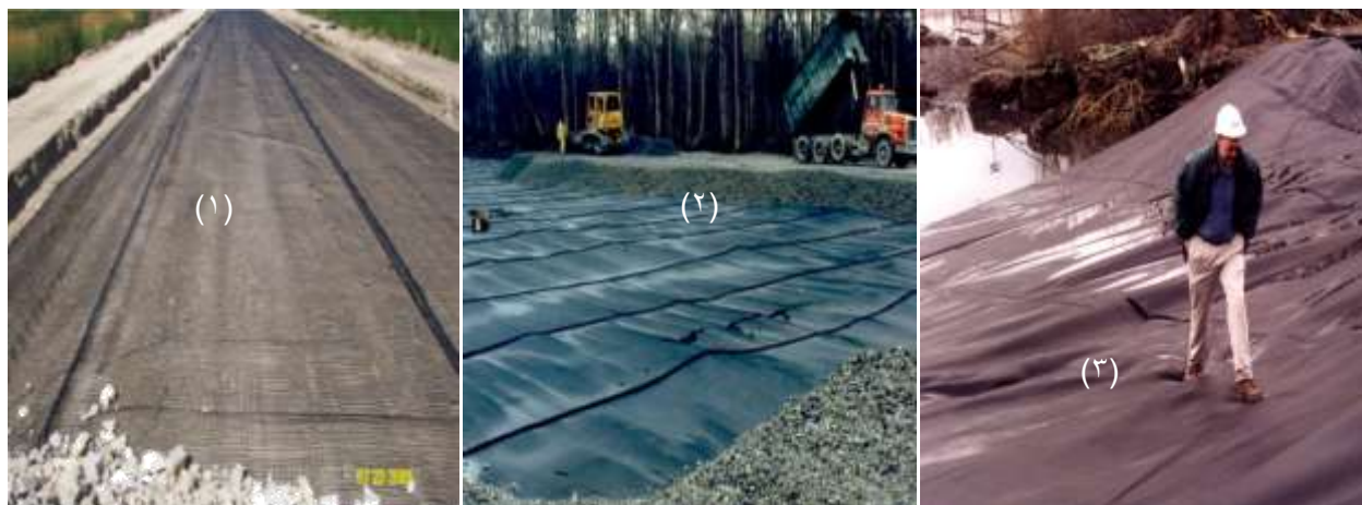
چگونگی تاثیر لایه ژئوسنتتیک در تسلیح و تثبیت بستر
